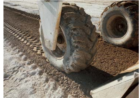
Traitement de sol
