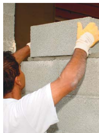
Montage de blocs
