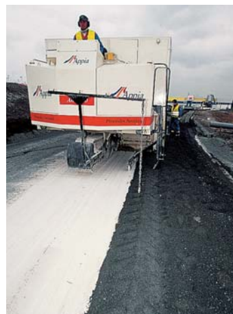
Retraitement de chaussée en place
