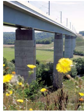
Viaduc de Jaulny - LGV Est
