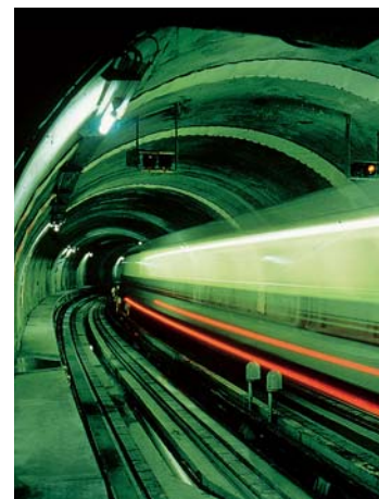
Voute consolidée par Jet grouting
