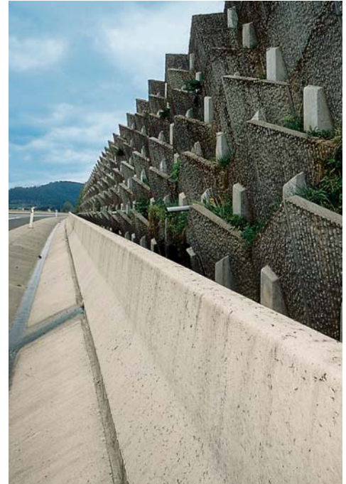
Glissière de sécurité - mur de soutènement
