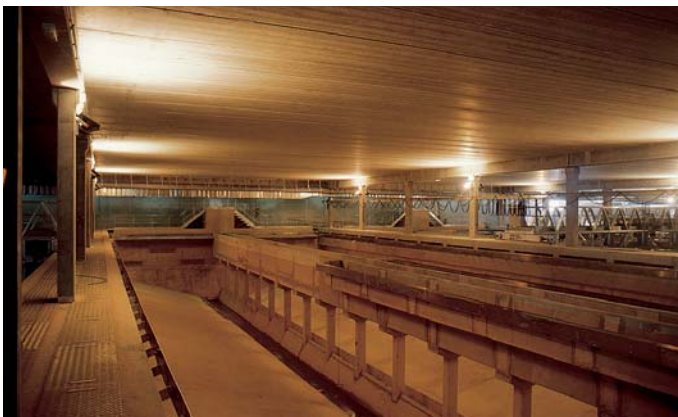
Station d'épuration - Bonneuil
