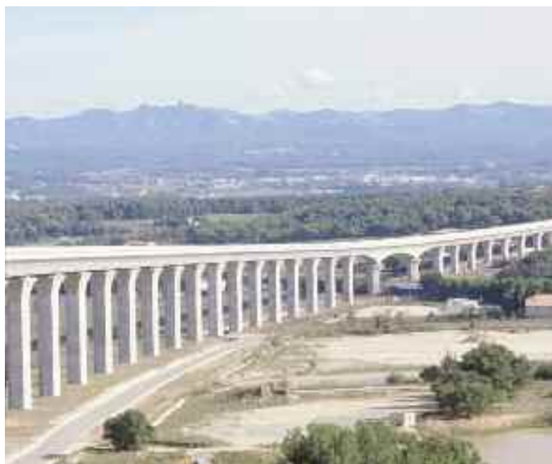
> Viaduc de Ventabren TGV Méditerranée (13).
