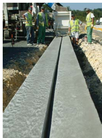
Bordures en béton extrudé
