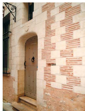
Rejointoiement de pierres et briques - Troyes
