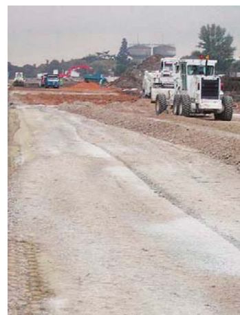
Traitement de la couche de forme au Ligex 16 EPR
