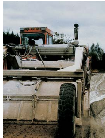
Traitement des sols
