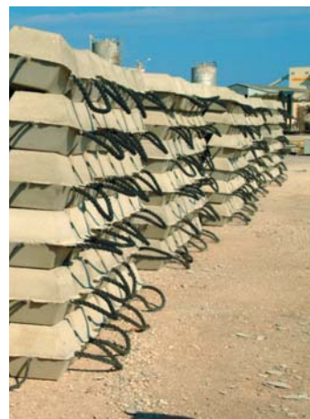
Préfabrication de matelas de lestage
