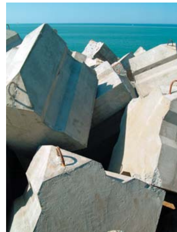
Blocs béton - Digue des cavaliers
