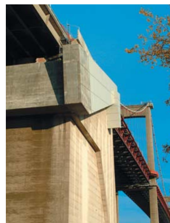
Mégapoutre - Pont d'Aquitaine
