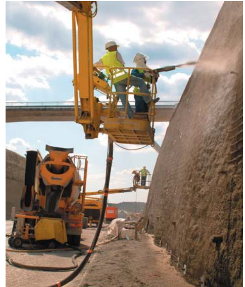
Béton projeté sur talus - Périgueux
