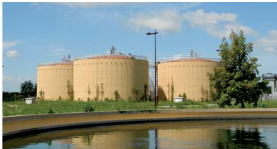
Station d'épuration de La Céreirède (34)
