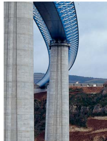
Viaduc de la Garrigue
