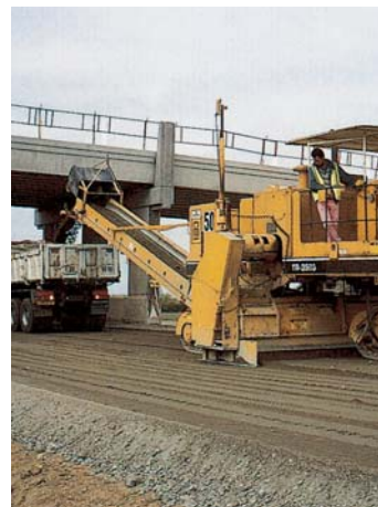
Mise en œuvre des matériaux traités sur chantier autoroutier
