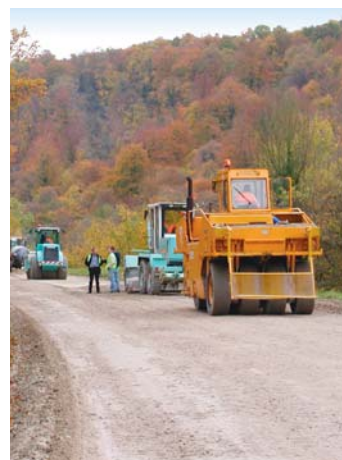
Traitement de sol
