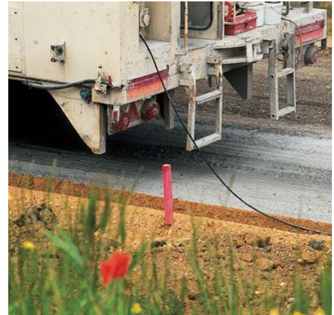
Retraitement de chaussée
