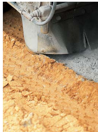
Retraitement de chaussée
