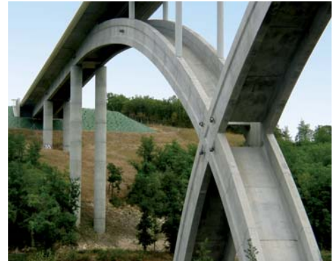
Viaduc de l'Anguienne
