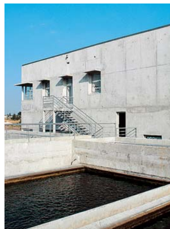
Station d'épuration - Bonneuil
