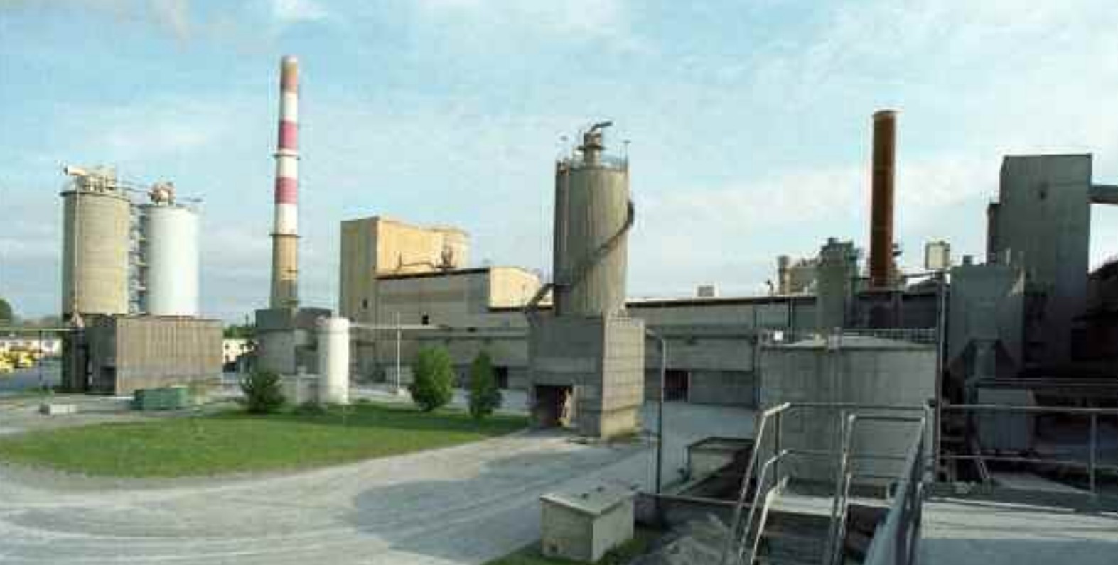
> Vue de l'usine de Ranville.
