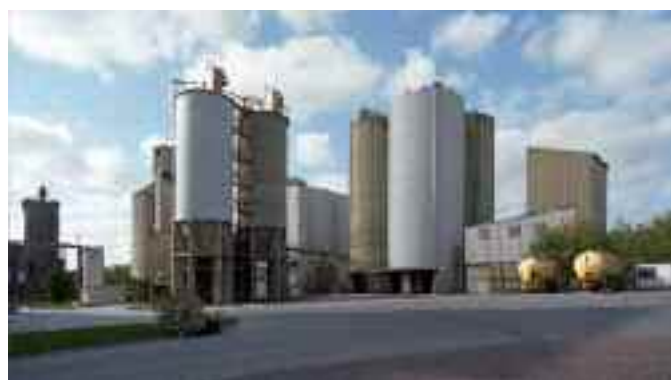
> Vue sur les silos de l'usine.
