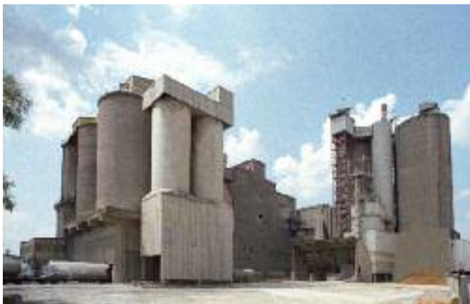
> Vue des silos de l'usine.
